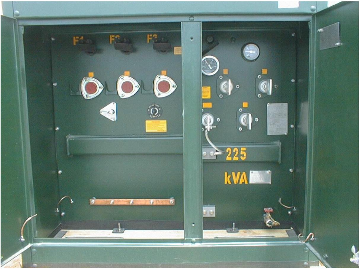
**De acuerdo a la Norma Mexicana, un transformador tipo pedestal se puede definir como el conjunto formado por un transformador, integrado a un gabinete totalmente cerrado, en el cual se incluyen accesorios y terminales para conectarse a los circuitos de distribución subterránea. Normalmente este conjunto está destinado para ser montado en un pedestal, para servicio y operación a la intemperie.**
