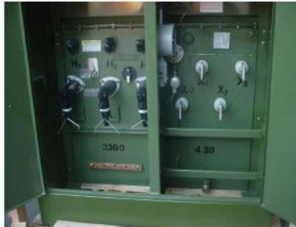
**Parte activa:** La parte activa del transformador tipo pedestal solo difiere de la de un transformador de distribución estandar en la localización y conexión de los terminales de alta y baja tensión. Estas modificaciones se hacen para facilitar la conexión adecuada de accesorios adicionales.
